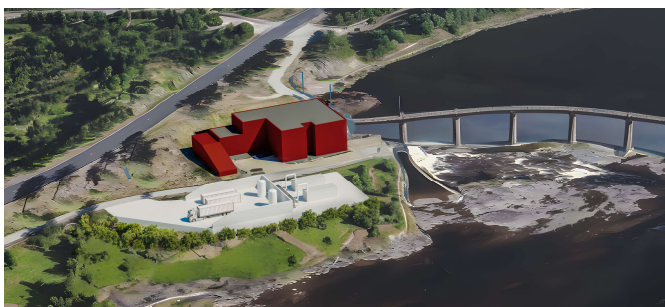
Pilotanlegg for hydrogenproduksjon ved Pikerfoss kraftverk
