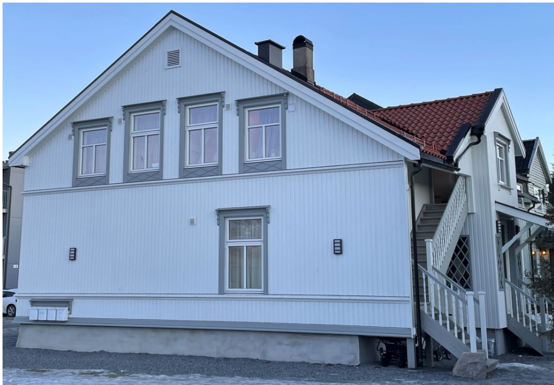
Abysgt 13 Restaurert og satt tilbake i original stand samt etterisolert innvendig og utvendig
