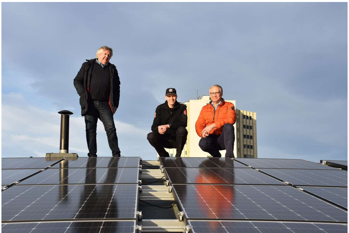
Solceller på Drammen Brannstasjon
