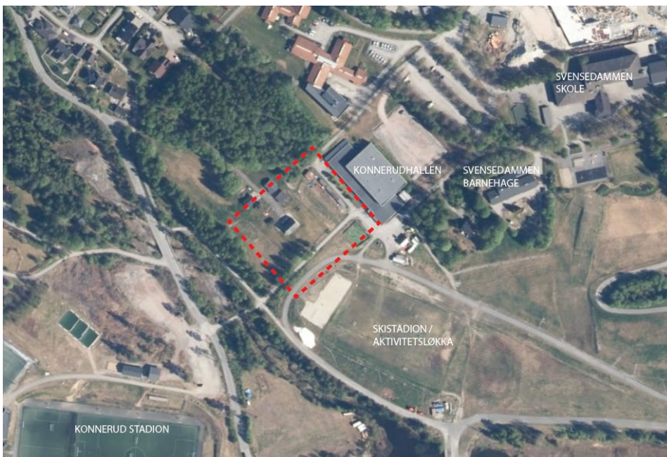
Figur 3 Flyfoto av dagens situasjon og planområdet. (Kilde: Drammen kommune).
