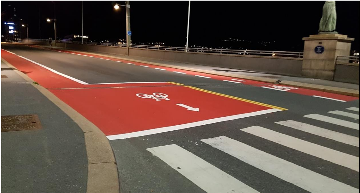
Figur 5 Eksempel på sykkelfelt fra bybrua i Drammen. Foto: EEV
