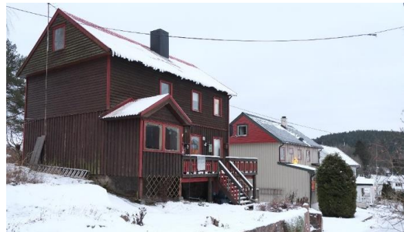
Nr 4 og 6 er ombygget og etterisolert. Gavlen har fått et merkelig uttrykk.
