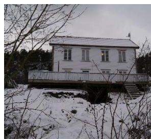
Terrasse/trapp Øvre gate
