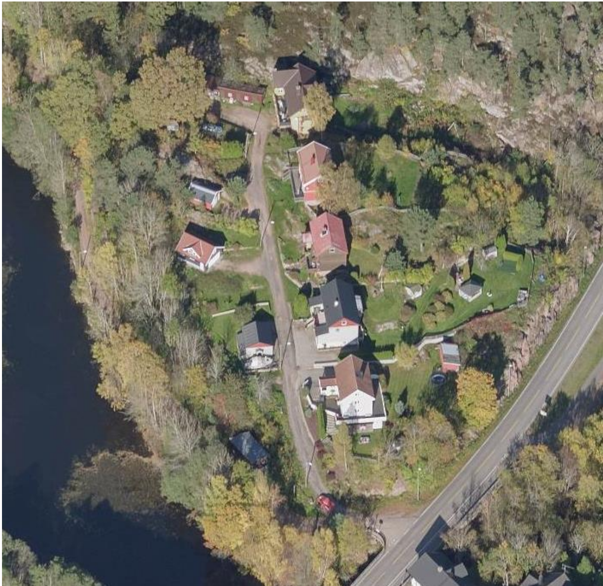
Torbjørnshaugen 2-10 (Kilde: 1881). Arbeiderboligene ligger på rekke og rad med enkle takflater og klare volumer. Det anbefales å følge samme retningslinjer som for øvrige arbeiderboliger, bl.a. med røde tegtak.
