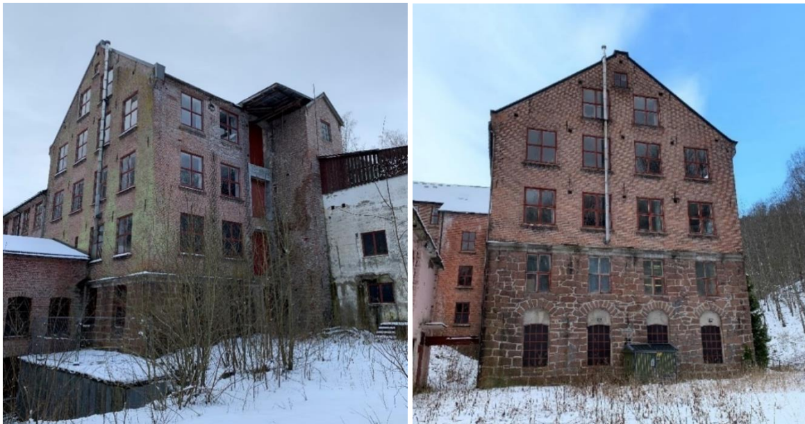
Bygning A og B (se kart side 30) fra første byggetrinn på Nedre Berger (NIKU 2020)
