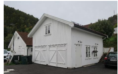
Nyere garasjer har større volum enn de eldre uthusene
