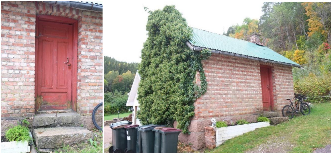
Til Skolebakken ligger et murt uthus med mange eldre/opprinnelige bygningsdeler bevart. Høy verneverdi. (NIKU 2020)
