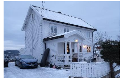
Nr 2 med nyere inngangsparti, men der volum er lesbart
