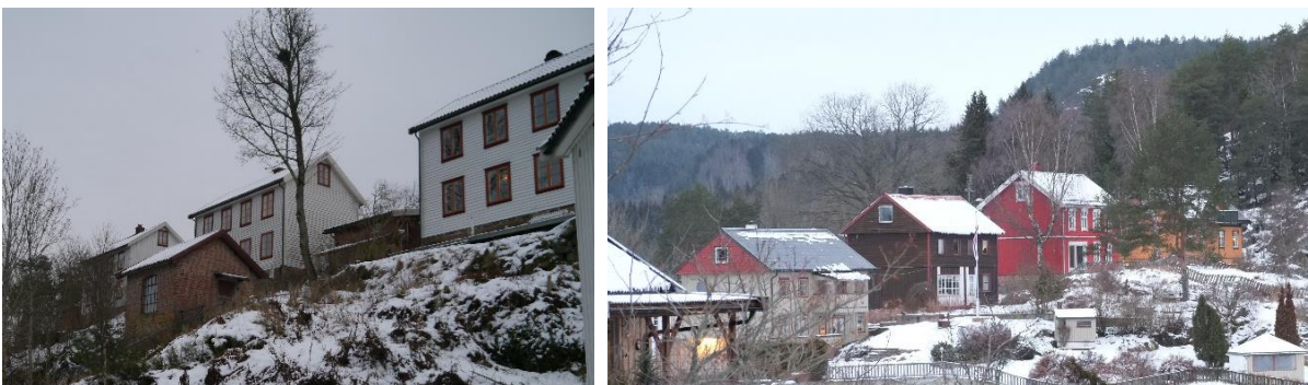
Boliger langs Fossekleiva på bildet til venstre, boliger på Torbjørnshaugen til høyre (NIKU 2019)
