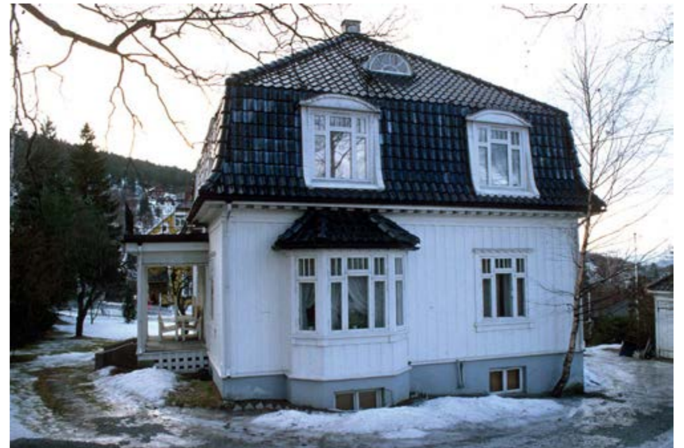
Barokkstilens mansardtak ble tatt opp igjen i jugendstilen. Da ble det vanlig med mansardtak bare på langsiden, som på Skogliveien 67 (lite bilde under). Konnerudgata 68 (over) er et av få jugendhus med et fullverdig mansardtak.
