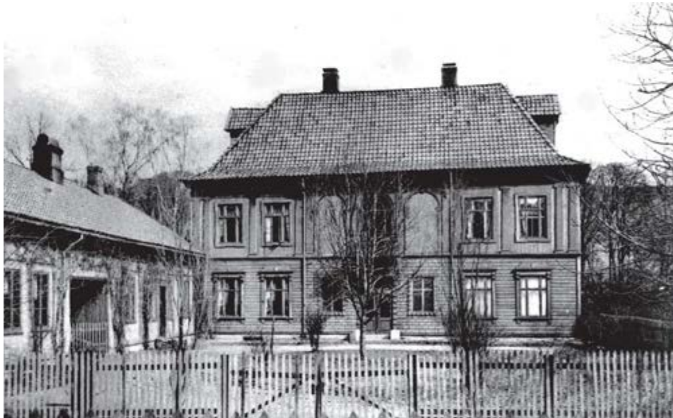
Hovedbygningen på Gulskogen er lite endret siden den ble bygd i 1800, og er det beste eksempel på Louis seize-stil i Drammen. De engelske skyvevinduene ble skiftet ut i 1880-årene. Blindvinduene på hver side av hoveddøren har beholdt det opprinnelige formatet til skyvevinduene, men er på bildet malt som korsvinduer. Postkort omkr. 1910
