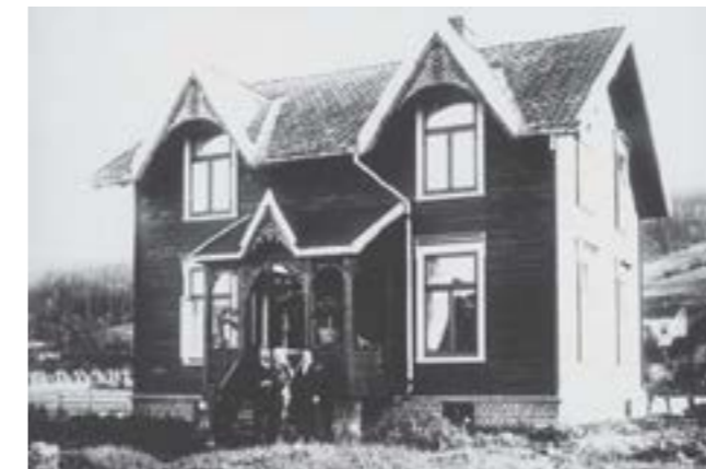
Fra omkring 1900 ble reisverkskonstruksjonene erstattet av lafteplank. Husene ble stående ukledde noen år. Verandaer med pulltak og sentralt arkoppbygg er typisk. Bolighus på Pukerud. Ludvig Bakke/JSA
