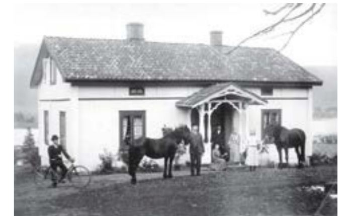
Sveitserstilens dekorative løvsagelementer var godt egnet til å modernisere eldre bygninger. Fasaden på Nordre Pukerud ble modernisert med åpent bislag i sveitserstil. Ludvig Bakke/JSA
