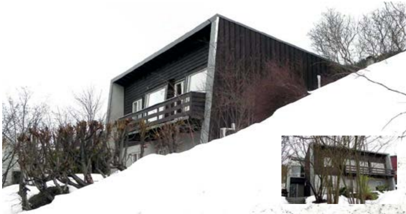
En utradisjonell og iøyenfallende villa i Strømliveien 23 ble tegnet av K. M. Fossen i 1958 for Reidar Gulbrandsen. Veggene ble murt av Siporex, blokker av gassbetong produsert ved Hokksund og etter finsk patent.
