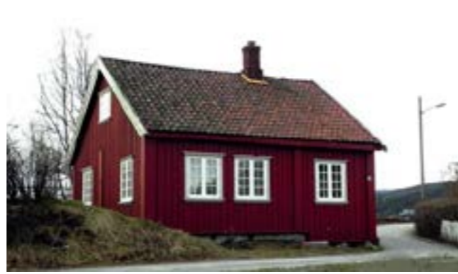
Grensegata 3 ble bygd på slutten av 1700-tallet som en ettroms stue, men ble senere forlenget og utvidet i bredden. Bildet viser huset etter at det ble rehabilitert og fasaden rekonstruert.
