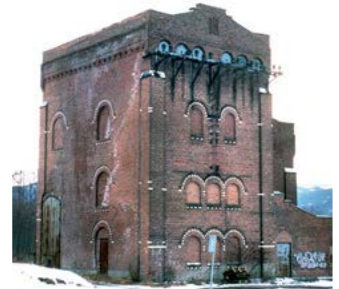
Transformatorstasjonen i Gosen (over).
