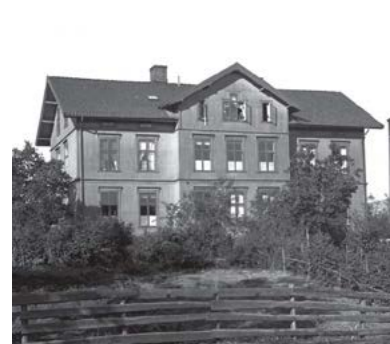
Et kommunalt bygg uten fordyrende detaljer er gamle Rødskog skole i Øvre Eikervei 16. Vinkelbygningen (se side 52) fra omkring 1890 har et fremskutt midtparti på fasaden mot øst. HCC
