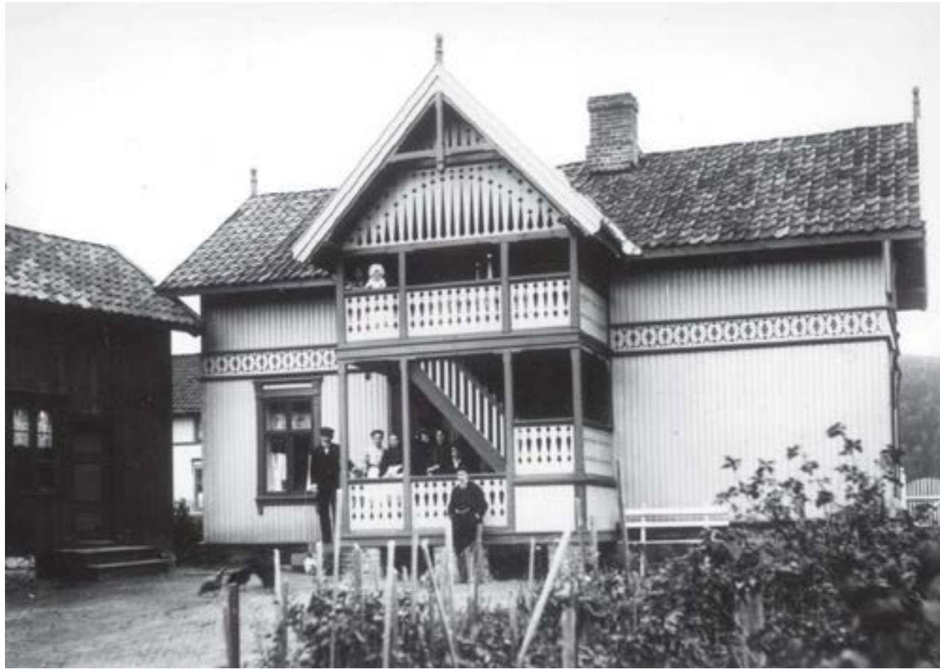
Bolighuset på småbruket Hagen i Øvre Eikervei 74 hadde kombinert veranda og trappehus mot gårdsplassen. Horisontalbåndet var sjeldent flott utført. Huset er senere brannskadet og ombygd. Ludvig Bakke/JSA
