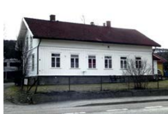
Hovedbygningen på Sundland (opprinnelig Søndre Sundland) ligger i Nedre Eikervei 11. Huset ble oppført i 1829 som enkesete for Smithestrøm.
