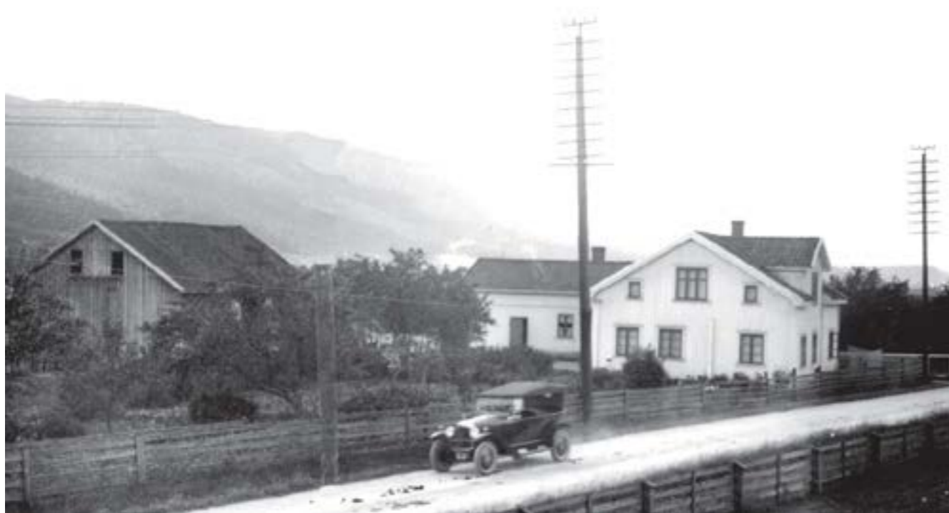
Bebyggelsen på Nordre Langum var representativ for en mindre gård. Våningshus, bryggerhus og låve dannet vegger i tunet, som åpner seg mot øst. Bygningene er revet i nyere tid. HCC 1920-årene
