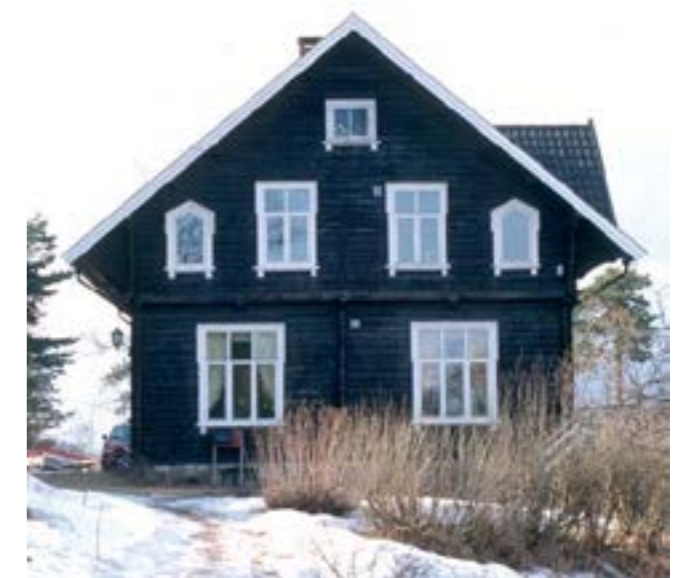
Konnerudgata 119 fra 1904 har mange elementer fra dragestilen, bl.a. synlig konstruksjon i lafteplank.
