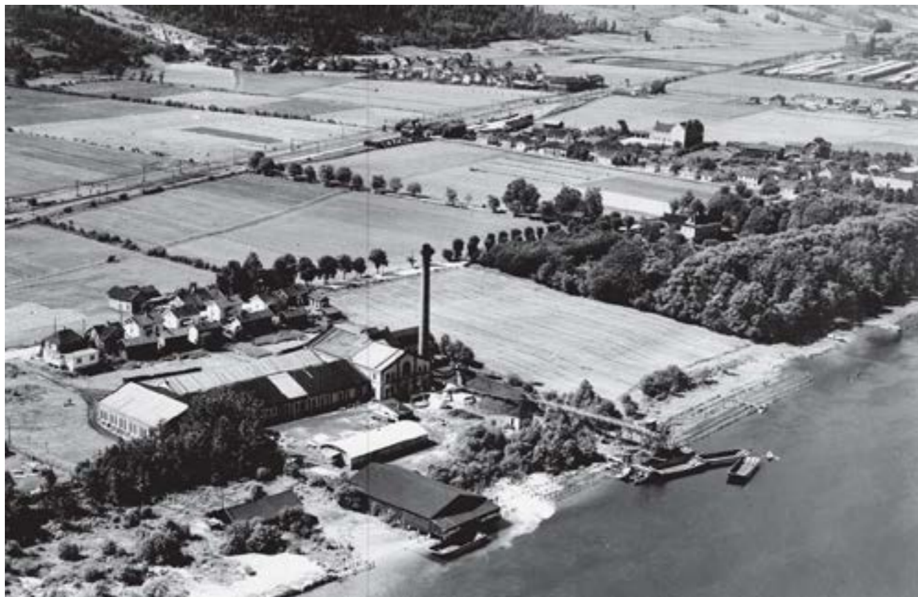
Et flyfoto fra rett før krigen viser at landbruket fortsatt sto sterkt i bydelen for en mannsalder siden. I forgrunnen ligger Sunland Papirfabrik og rekken av arbeiderboliger langs Nedre Eikervei. Til høyre skimtes hovedbygningen på lystgården Gulskogen mellom parkens tette bladverk. Rødskog skole rager opp blant boligene på Brandteløkken. Bebyggelsen knytter Gulskogen stasjon til Landfalløybrua (utenfor bildet). Øverst i høyre hjørne ligger Gulskogen Cellulosefabrik med lagre av tømmer, og mot åsen ser vi en klynge hus langs Rødgata. Drammen kommune.
