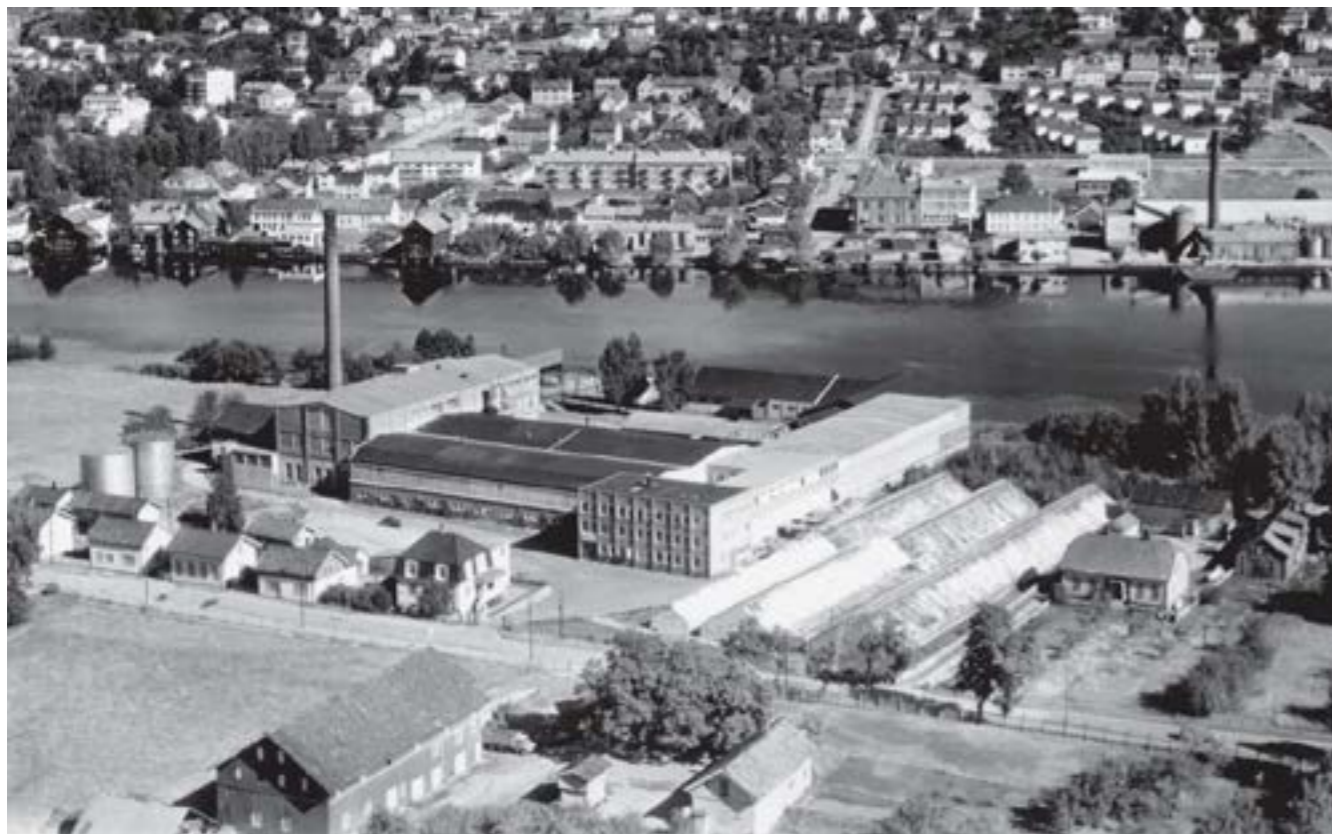
Sunland Papirfabrik ble etablert i 1912. Bildet fra 1959 viser anlegget som ble bygd etter brannen i 1946. Fabrikken ble slått sammen med Eker Papirfabrik til Sunland-Eker Papirfabrikker i 1971. Langs Nedre Eikervei (i forgrunnen) ligger arbeiderboliger. Grønvold gård ytterst til høyre er senere revet for å gi plass til nytt ferdigvarelager. A. Schröder, Widerøes Flyveselskap/DK
