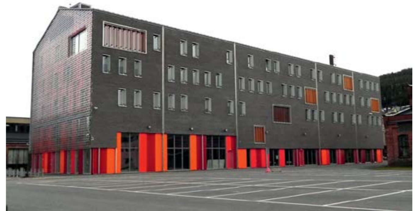
NSBs kompetansesenter på Campus Sundland (over) ble ferdigstilt i 2010 som det første næringsbygg i Norge som tilfredstilte energiklasse A. Lameller på fasaden beveger seg etter sola og slipper inn dagslyset samtidig som varmeinngangen reduseres til 15%. Dette grensesprengende prosjektet er signert Alt.arkitektur.
