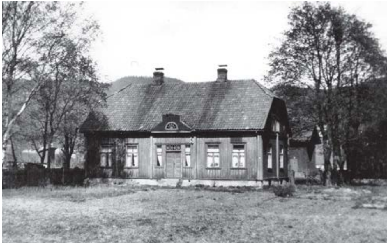
Våningshuset på Grønvoll var en verdig representant for empiren i Strømsgodset. Huset var i god stand og godt bevart da det ble revet i 1980-årene. Drammens Museum
