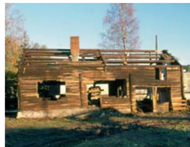
Nedre Eikervei 22 under riving i 1989. Bygningen fra omkring 1700 har utkraget overetasje og var trolig sommerbolig for sagbrukseier Mads Wiel.
