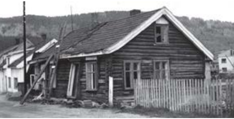
Sundhauggata 13 var en av de større bygningene på Sundhaugen for 200 år siden. Da huset ble revet i 1958 ble den tradisjonelle laftekonstruksjonen avdekket.
