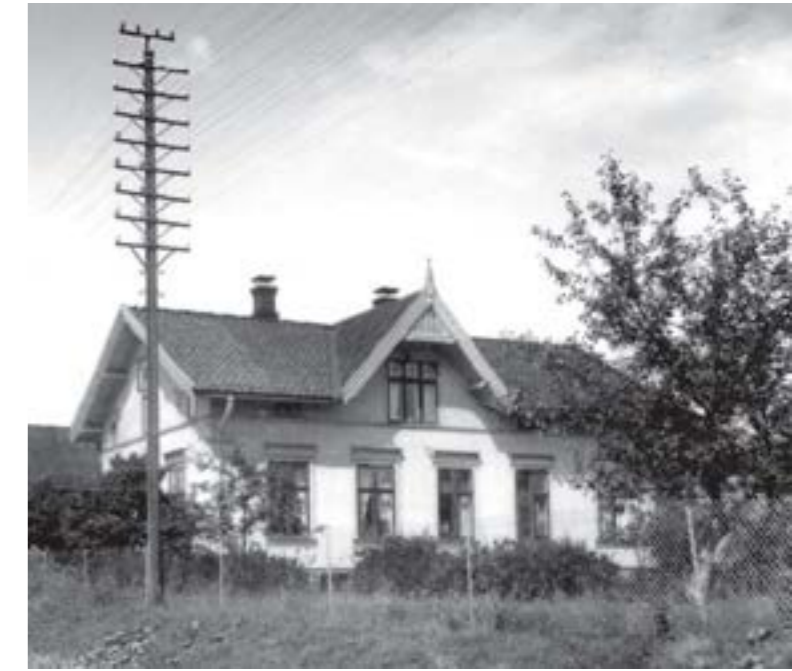
Våningshuset på Østre Langum fra 1891 var en tradisjonell representant for sveitserstilen. Gavlveggen mot sør var utformet som veranda. Huset ble ødelagt av brann i 1995 og revet.
