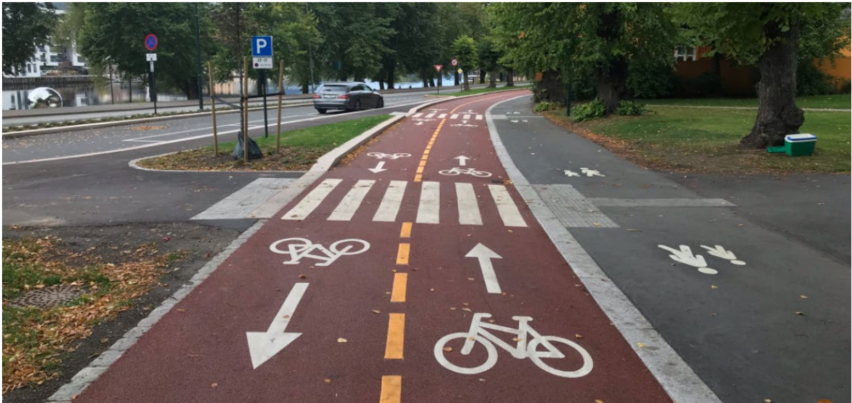
Sykelvei med fortau gjennom Drammen park.
