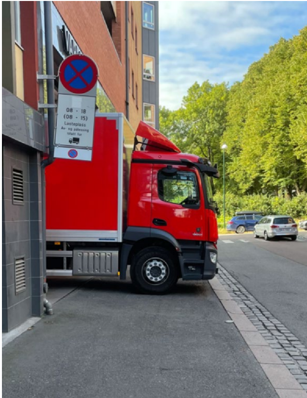
Eksempel på vareleveringsløsning som er bygget for kort i forhold til funksjonen bygget betjener.
