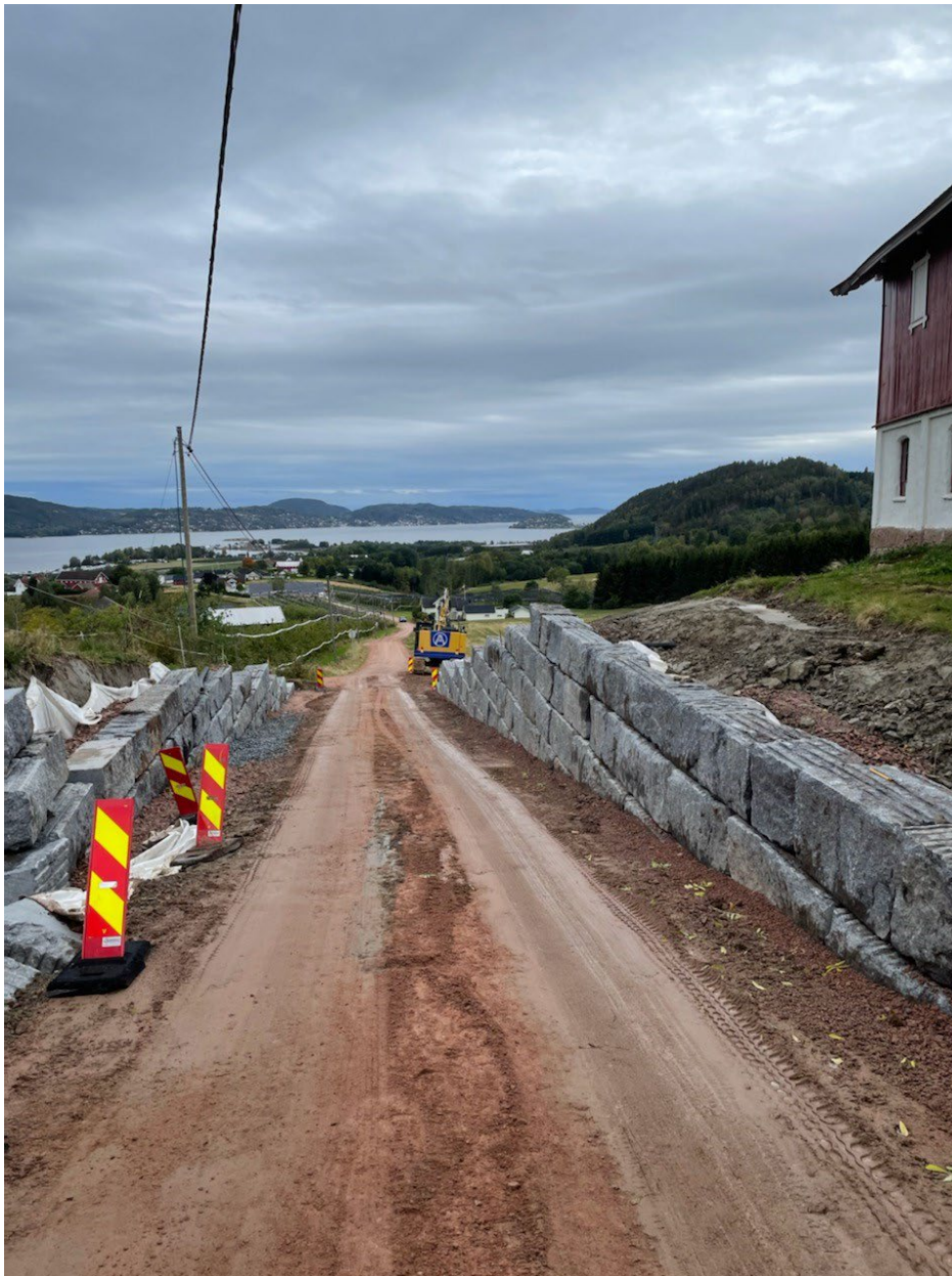
Ny opparbeidelse av Eikveien med støttemurer
