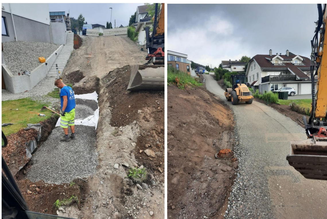
Opparbeidelse av ny gang- og sykkelvei i 'Singelen'
