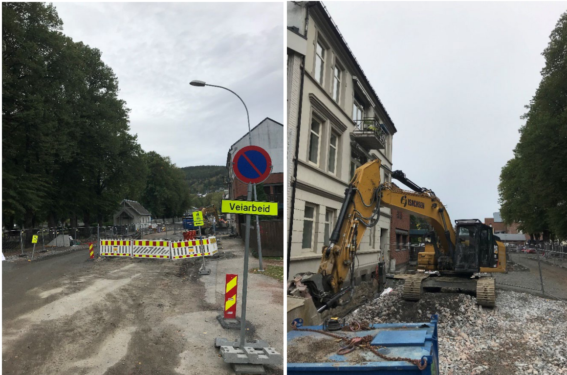
Ombygging av Knoffs gate
