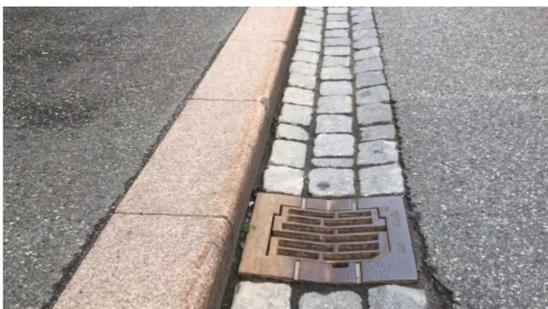
Bred rød granittkantstein med tilliggende rennebunn slik brukt i Drammen sentrum. I Mjøndalen brukes ikke rennebunn.
