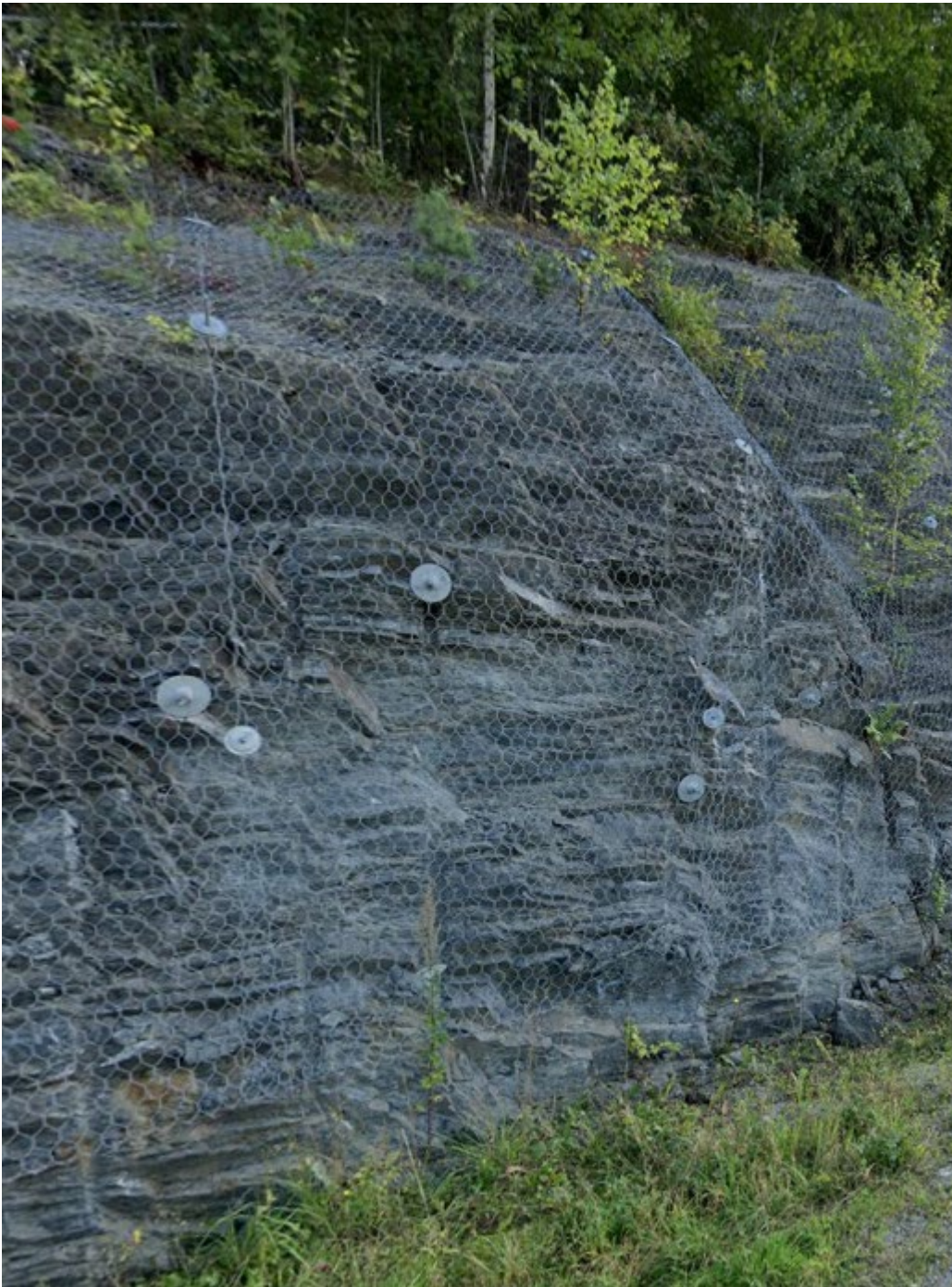
Fjellsikring i Hagatjernveien
