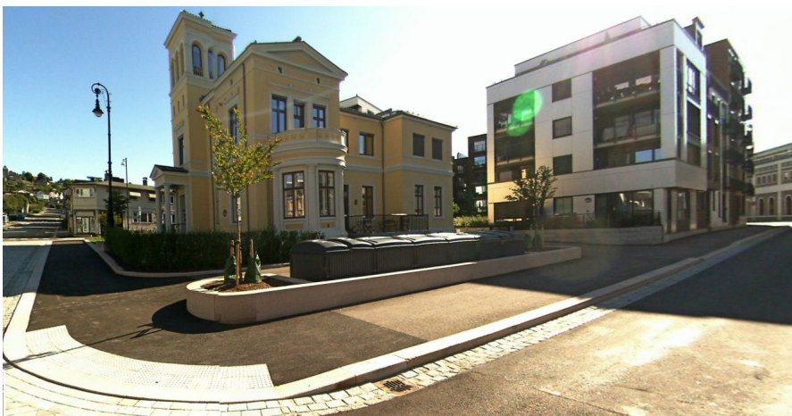
Løsning for nedgravd renovasjon innarbeidet i gateutforming – Ole Steens gate
