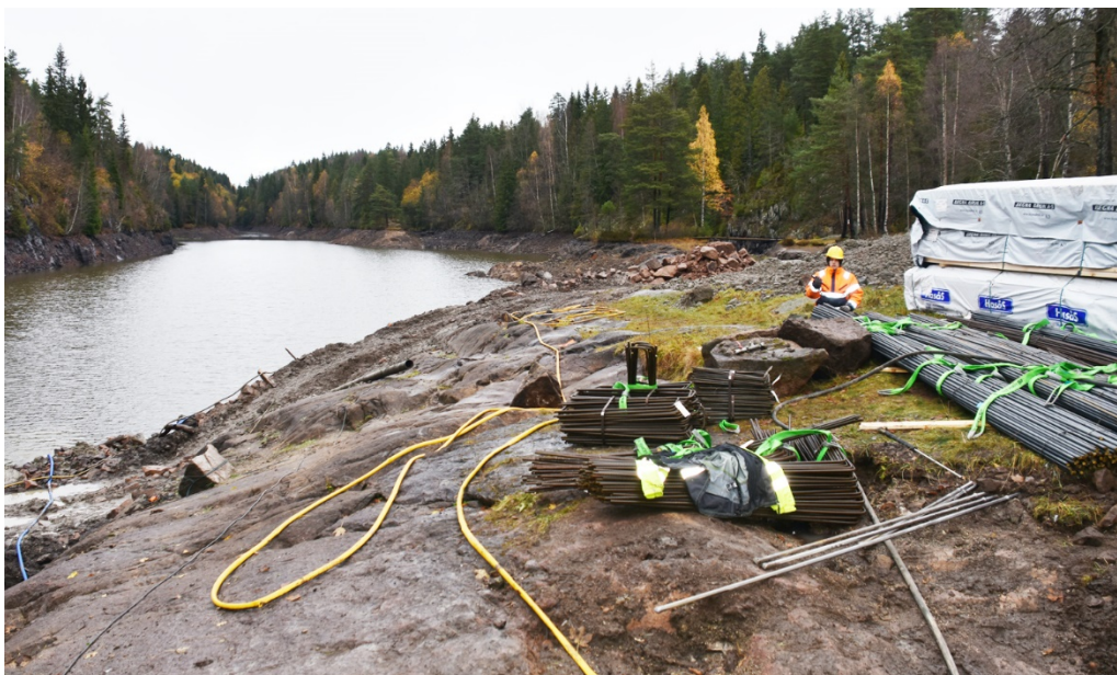
Kloptjern – rehabilitering av dammuren
