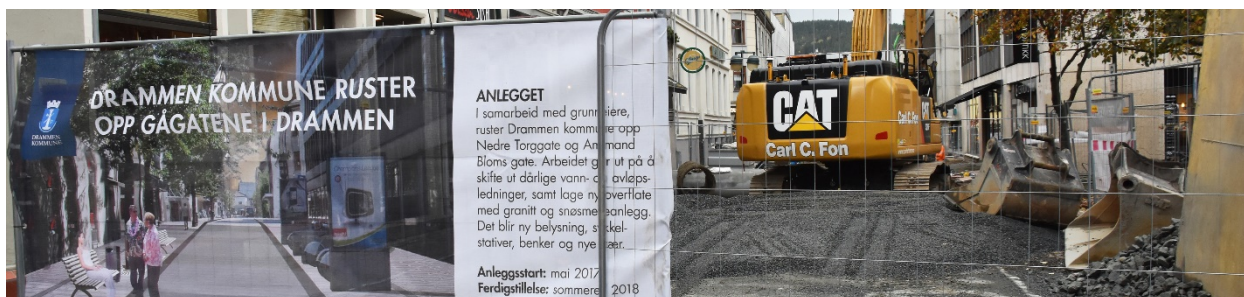
Vann- og avløpsledninger skiftes ut når gågatene på Bragernes rustes opp
