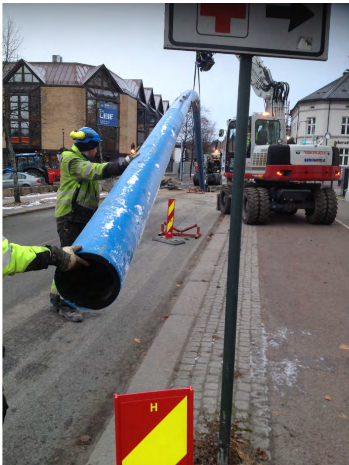
Inntrekning av ny vannledning i Hauges gate
