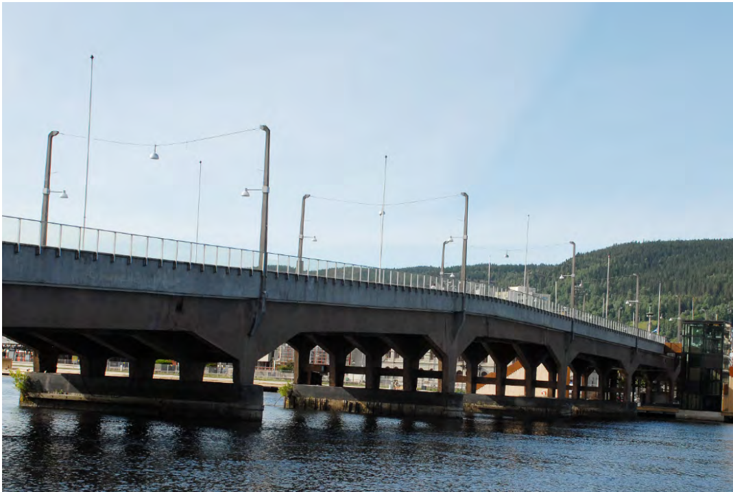
Bybrua i Drammen
