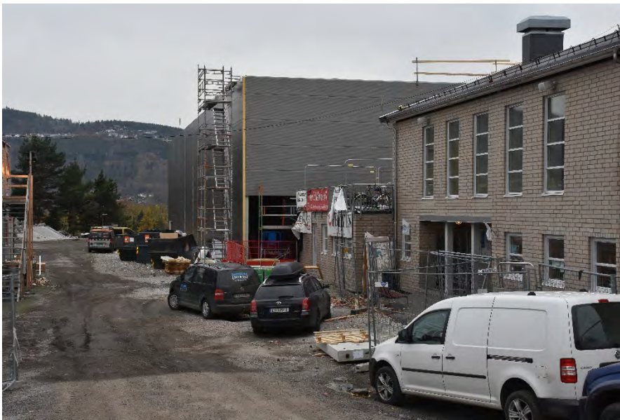
Bygging av ny flerbrukshall ved Øren skole
