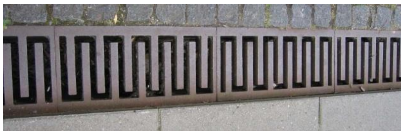
Figur 6-5 Eksempel på overvannsrister
