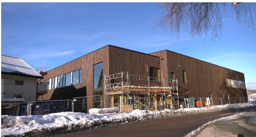
Ny flerbrukshall ved Brandengen skole er under bygging
