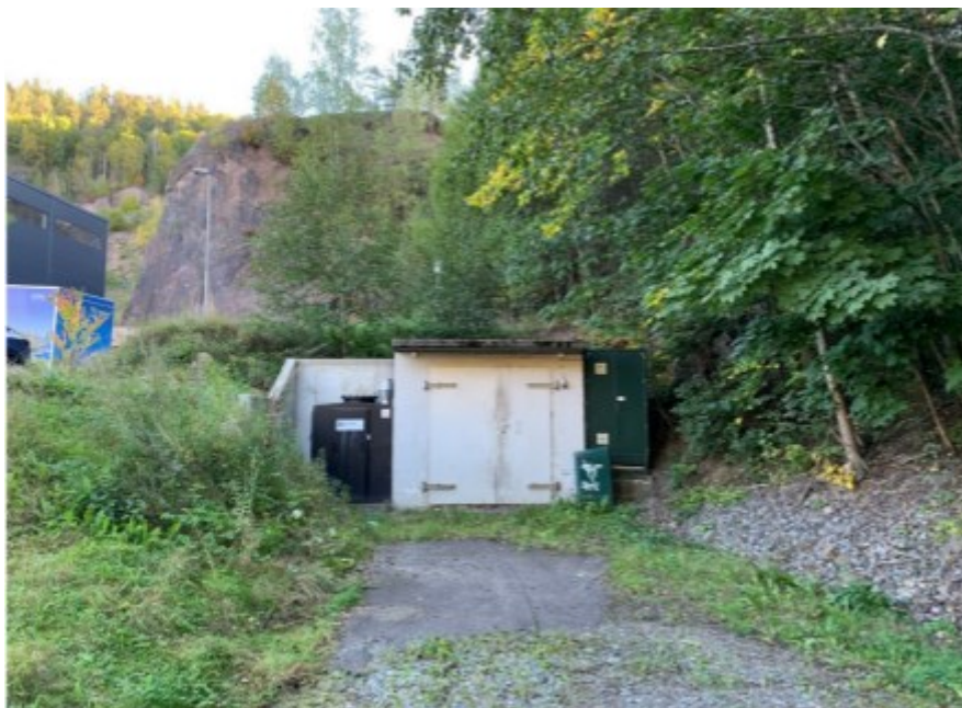
Figur 5. Eksisterende lukehus. Bilde Norconsult.
